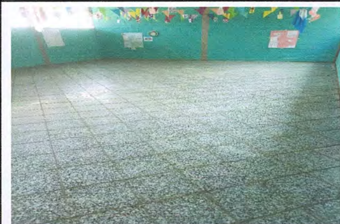
Foto 4: EL PISO DE EL AULA Y DE AFUERA DE LA ESCUELA SE CAMBIARON POR PISO DE GRANITO.
