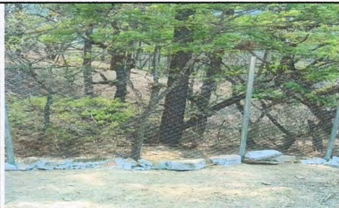
Foto 1: SE PUSO MAYA Y TUBOS DE METAL PARA CIRCULAR LA ESCUELA.
